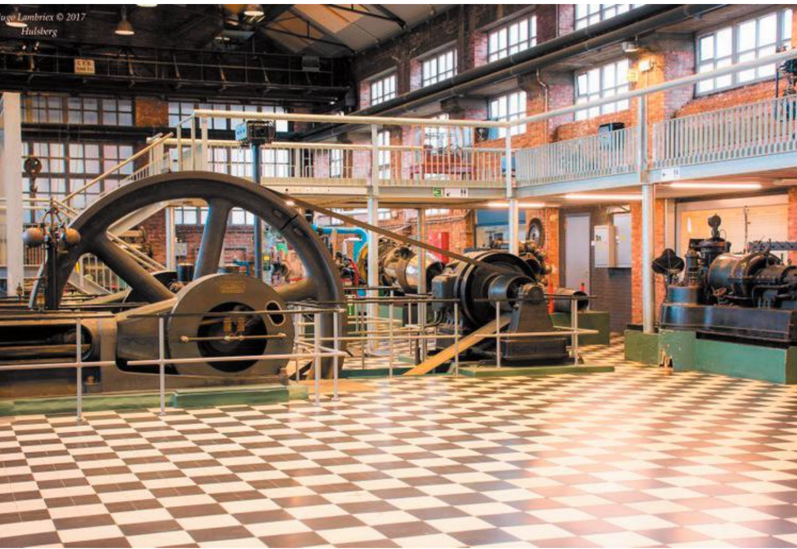
Thermotechnisch Instituut - grote Bollinckx stoommachine, KU Leuven
